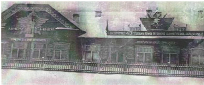
Здание Дома народов Севера. Сосьва. Березовский район. 1930-е гг.
